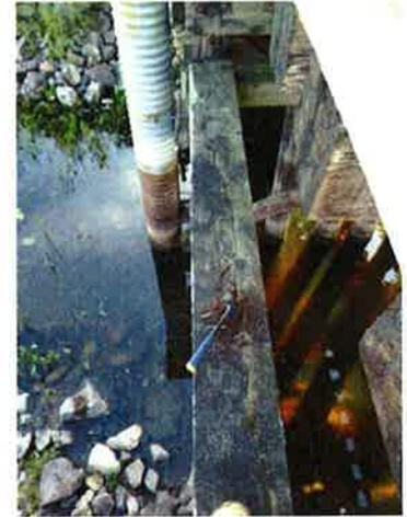
Span 1 longitudinal brace. Note rot.
