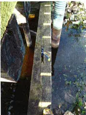
Span 2 longitudinal brace. Note rot.
